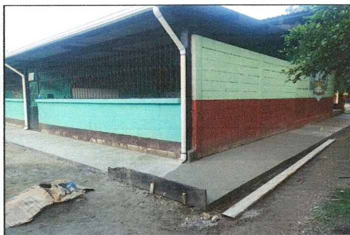
Foto 3: Mejoramiento de banqueta peatonal a escuadra.
