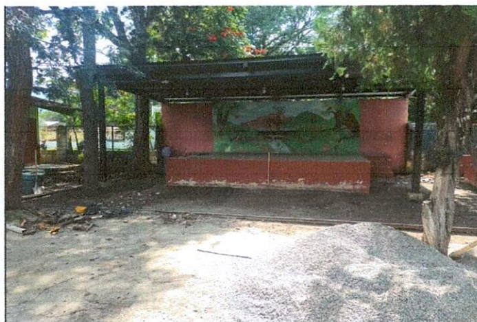
Foto 4: Mejoramiento de losa de patio.
